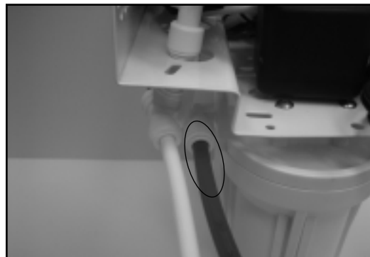
Figure 8 - Installer la membrane sans y toucher
