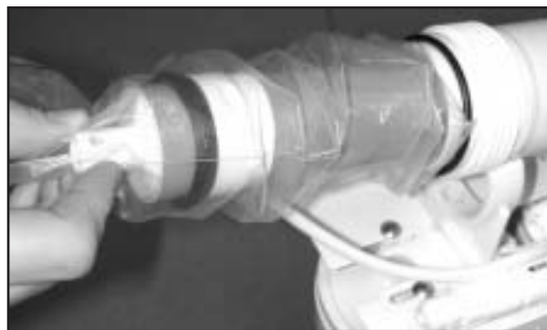
Figure 8 - Installer la membrane sans y toucher
