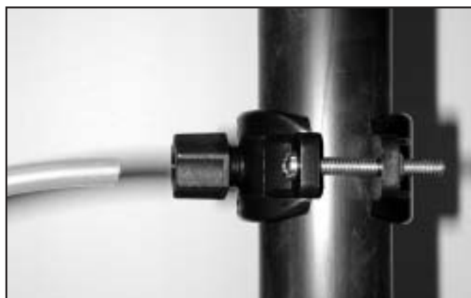
Figure 4 - Assemblage de la selle du drain
