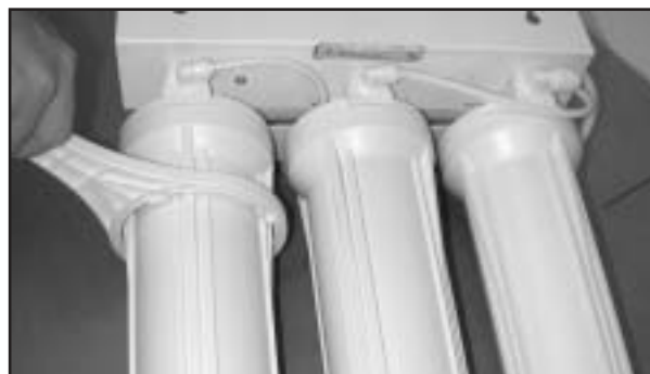
Figure 11 - Usage de la clé à carter pour le remplacement des cartouches à filtre.
